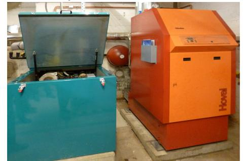
BHKW (geöffnet) und Spitzenlastkessel
