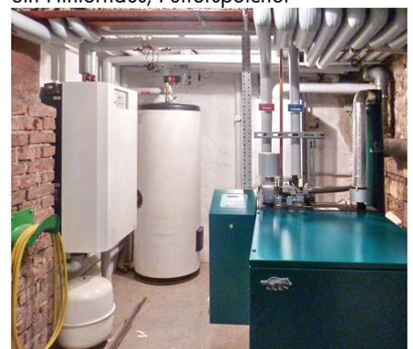
BHKW, li. Wärme-Übergabestation für ein Hinterhaus; hinten ein Warmwasserspeicher
