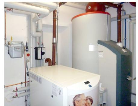
BHKW (Bildmitte), im Hintergrund der Speicher mit Vorbau für die Brennwerttherme; BHKW-Gaszähler (hinten links)
