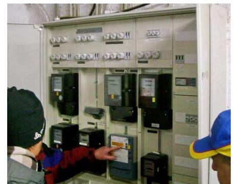
Stromzählerschrank samt Zweirichtungszähler (grau) für Netzeinspeisung und Zusatzstrom, Unterzähler und ein Hauptzähler für die Wohnungen sowie der Allgemeinstromzähler
