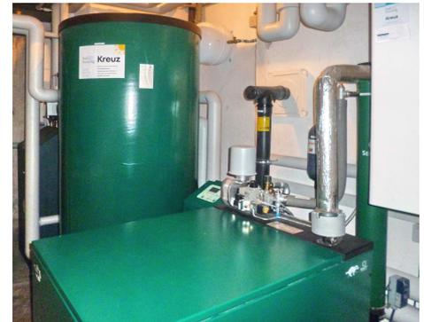
BHKW mit Abgaswärmetauscher (re.); Speicher
