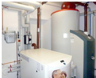
Oben: Schema Mini-BHKW (1), Mini-BHKW mit Wärmespeicher mit integrierter Zusatzheizung
