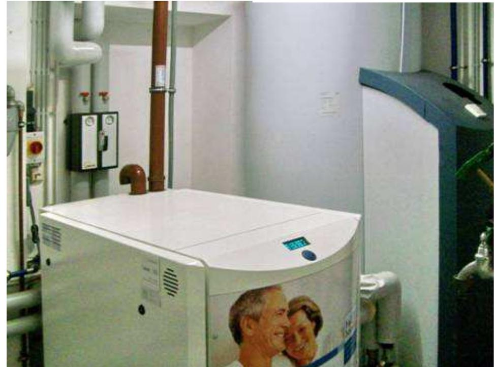
**Mini-BHKW (modulierend 1 – 5 kWel) ersetzt Etagenheizungen**
