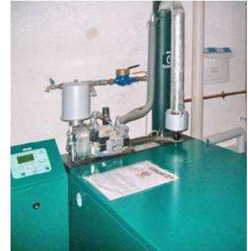
**Mini-BHKW + Wärmedämmung in denkmalgeschütztem Doppel-MFH**
