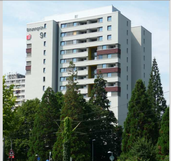
Die Ostfassade nach der Vollmodernisierung, im Hintergrund die unsanierte Bugginger Straße 2.
