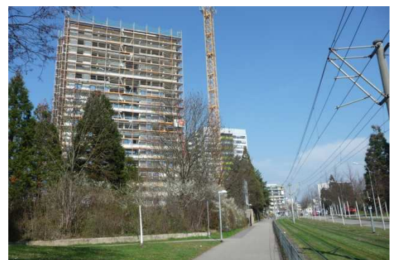
Süddansicht während der Bauphase, im Hintergrund das zertifizierte Passivhaus Bugginger Straße 50.
