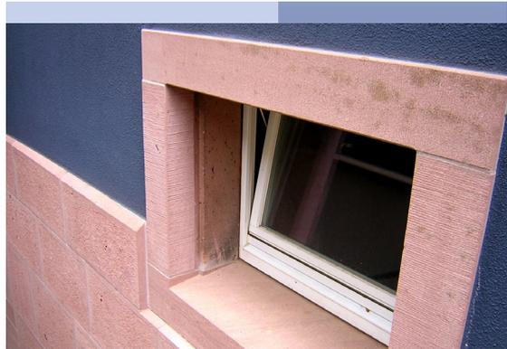
Die Ostfassade wurde, auf Vorgaben des Denkmalschutzes, ohne zusätzlich Dämmung belassen und nur mit einem Wärmedämmputz versehen.
