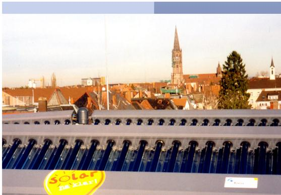
Die Glasröhren sind mit einem hochreflektierenden Flachspiegel hinterlegt, so dass auch bei ungünstigen Einstrahlwinkeln der Sonne und bei diffusem Licht Wärme gewonnen wird.
