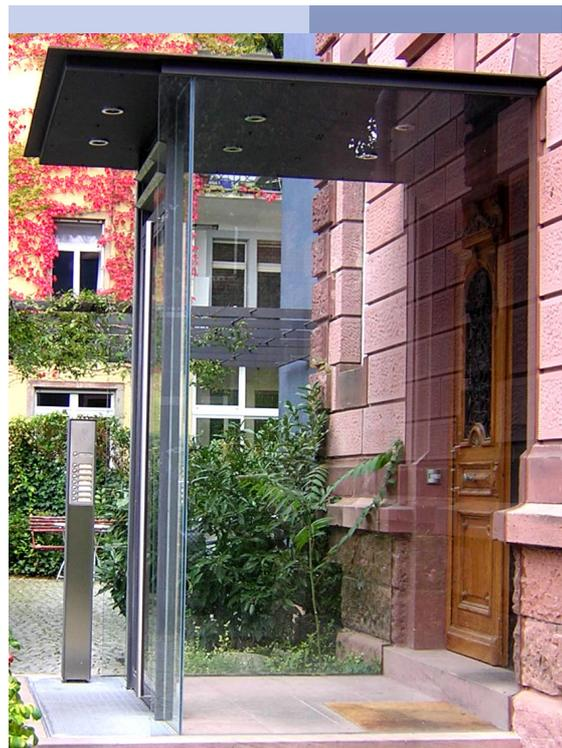
Aus dem gleichen Grund wurde ein neuer Windfang gebaut. So konnte die aufwendig gearbeitete, historische Massivholztür mit Einfachverglasung trotz ihres schlechten Wärmedurchgangskoeffizient von  $4,5 \text{ W/m}^2\text{K}$  erhalten bleiben. Die farbigen Treppenhausfenster wurden zu Kastenfenstern umgebaut. Der U-Wert verbesserte sich dadurch von  $5,2$  auf  $2,5 \text{ W/m}^2\text{K}$ .
