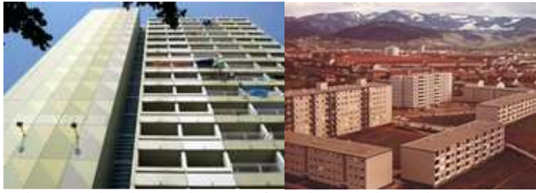
Sanierungsgebäude Bugginger Straße 50 im Quartier Weingarten. copyright: Freiburger Stadtbau GmbH Blick auf das Quartier Weingarten in Freiburg. copyright: Freiburger Stadtbau GmbH
