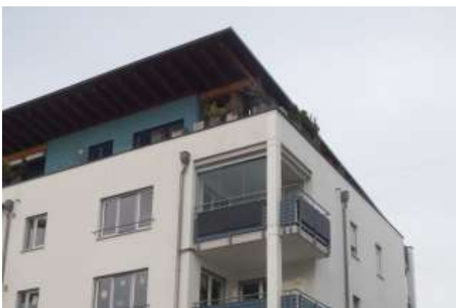
Besichtigte zweiseitige Balkon-PV-Anlage in Freiburg-Rieselfeld
