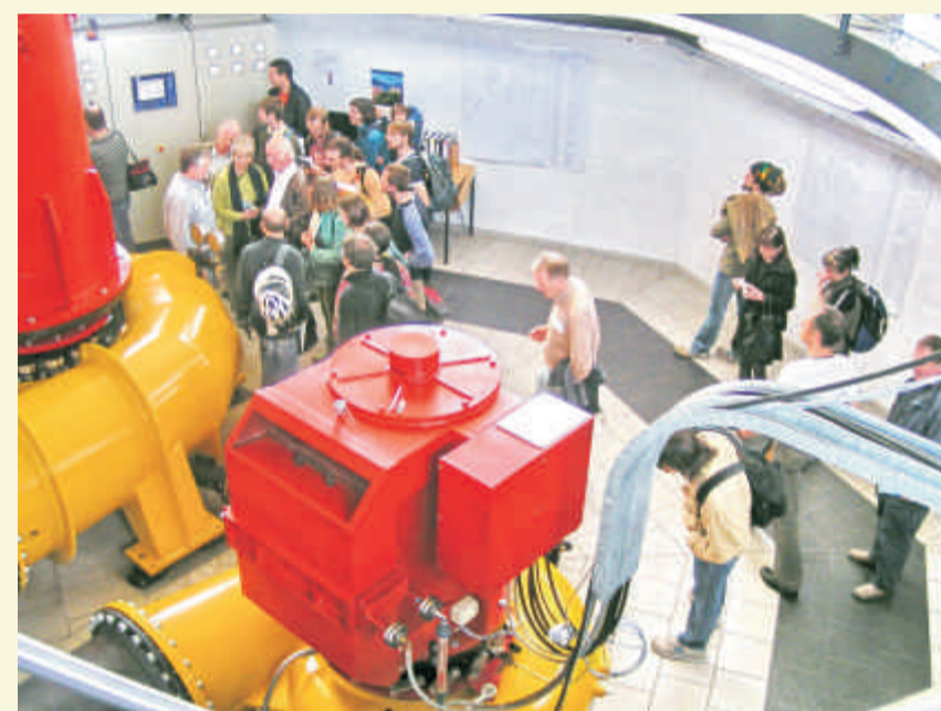
Zukunftsfabrik der Wasserkraft Volk AG, Gutach-Bleibach
