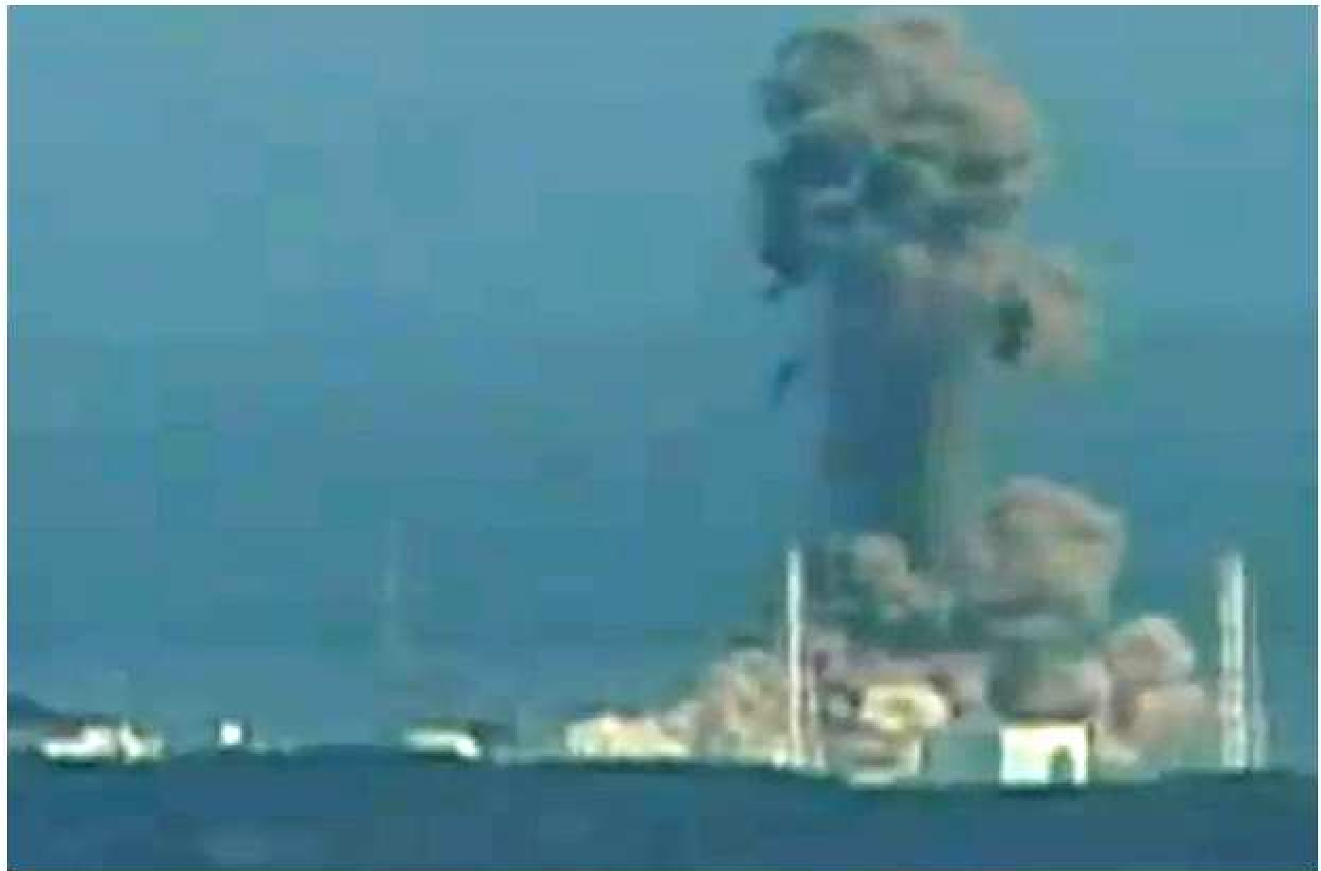
Eine riesige Rauchwolke steigt aus dem Reaktor 3 des Kernkraftwerks in Fukushima auf. Bei einer Wasserstoffexplosion wurde angeblich nur das Dach des Gebäudes zerstört. Mehrere Arbeiter wurden verletzt. © AFP/HO/NHK www.gmx.net/themen/nachrichten/bildergalerien/bilder/967czw0-chaos-nach-dem-beben#/cid12363696/21
