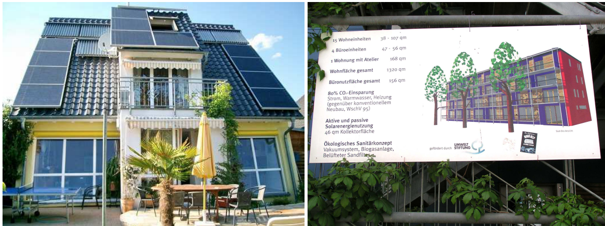
links: Passivhaus mit Solarwärme- und Solarstromanlage, Breisach (Foto G. Löser)
