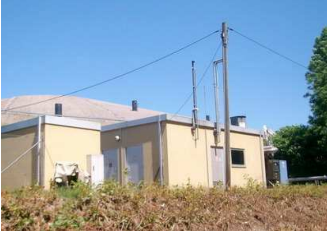
Deponiegasstation; re.: die beiden Schlechtgas-Gasturbinen-BHKWs (seit 2006, 2 x 65 kW el; 1 Mio kWhel/Jahr, gefördert von UM Baden-Württemberg) liefern auch Wärme zur Speiserestesterilisation. Soweit das Deponiegas für Motor-BHKWs zu methanarm ist, wird es hier für die Gasturbinen zuvor auf 6 bar verdichtet. Soweit das Deponiegas genügend Methan enthält, wird es zu den Motor-BHKWs in Freiburg-Landwasser geleitet. Nur ein kleiner Teil des Schlechtgases wird noch abgefackelt.
