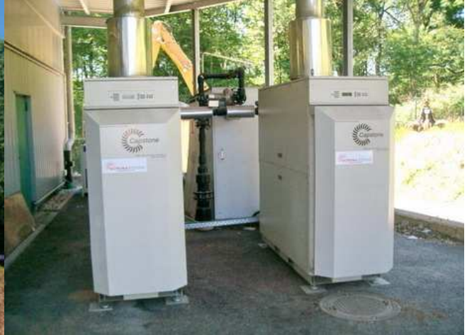
Deponiegasstation; re.: die beiden Schlechtgas-Gasturbinen-BHKWs (seit 2006, 2 x 65 kW el; 1 Mio kWhel/Jahr, gefördert von UM Baden-Württemberg) liefern auch Wärme zur Speiserestesterilisation. Soweit das Deponiegas für Motor-BHKWs zu methanarm ist, wird es hier für die Gasturbinen zuvor auf 6 bar verdichtet. Soweit das Deponiegas genügend Methan enthält, wird es zu den Motor-BHKWs in Freiburg-Landwasser geleitet. Nur ein kleiner Teil des Schlechtgases wird noch abgefackelt.
