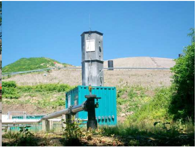
auf dem Weg zu Speiseresteaufbereitung re.: hier startet die Deponiegasleitung zu den BHKWs in Freiburg-Landwasser (seit 1991)
