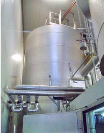
li.: Wärmepufferspeicher für Gasturbinen und Speiserestesterilisation, re: Sperrmüllzwischenlager
