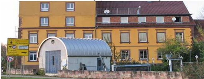
EM: Wasserkraftwerk EEE bei der Mündinger Mühle
