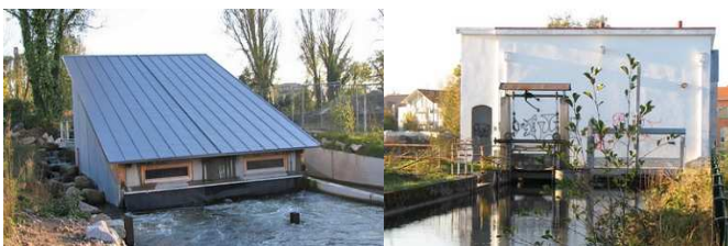
EM: Schneckenkraftwerk Kreuz (li.) & Wasserkraftwerk, Ramie-Gelände
